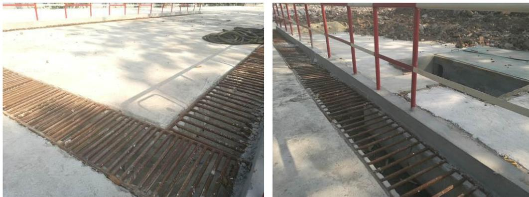
图 6.4 建筑垃圾冲洗场地排水沟及沉砂池
